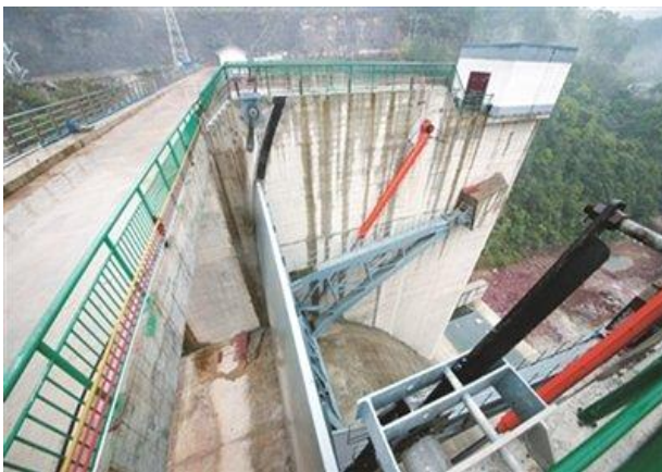
广西古偿河水电站（QHLY 系列）
