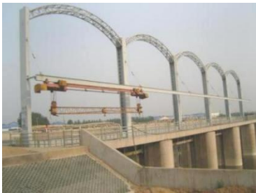
山东临沂引沭入涑工程（柱塞式液压启闭机）
