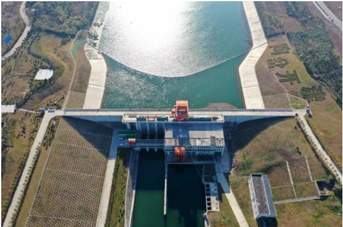
鄂北调水丹江口水库渠首工程 (QHSY 系列)
