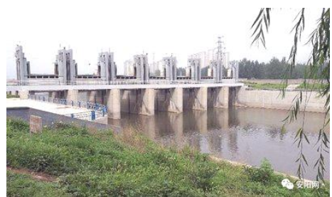
河南安阳于曹闸水位调节坝工程（柱塞式液压启闭机）
