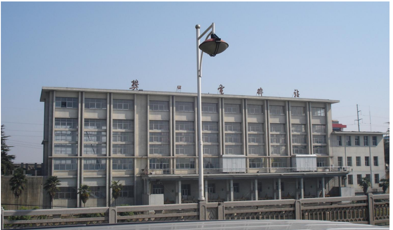
长江防洪工程湖北樊口电排站（QPKY 系列）
