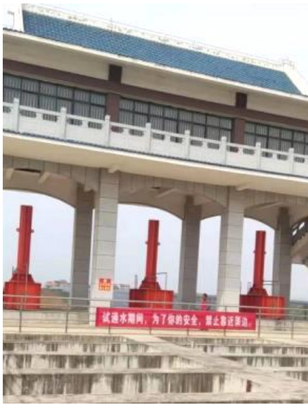
鄂北地区水源配置工程（QPPY 系列）
