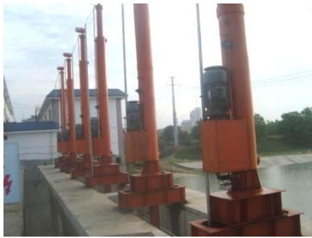
湖北汉川泵站工程（集成式液压启闭机）
