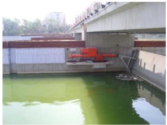
山东维坊城市防洪工程（集成式液压启闭机）
