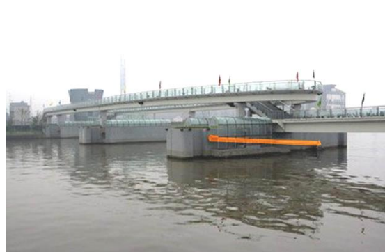
江苏无锡城市防洪工程江尖水利枢纽（翻转式卧倒闸门液压启闭机）
