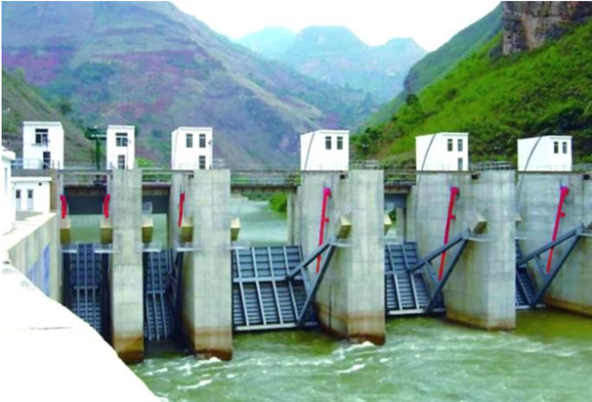
牛栏江红石岩堰塞湖工程 (QHSY5500KN 及 QHLY4000KN 陶瓷活塞杆液压式启闭机)
